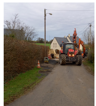
Travaux rue des ifs
