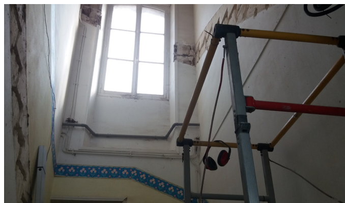
Destruction de l'escalier menant au logement de l'étage
