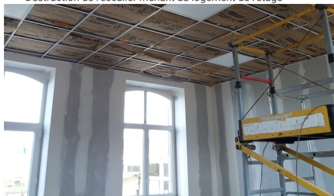
Amélioration de l'isolation et abaissement du plafond
